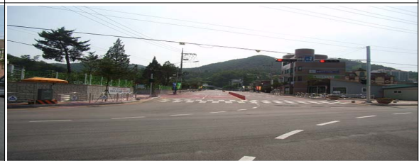
양구군 비봉초교 앞 4차선도로개설
