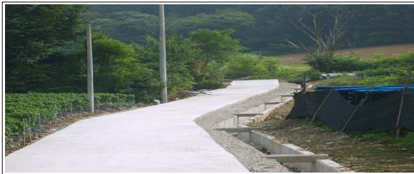
춘천시 마을안길 포장 및 배수로정비
