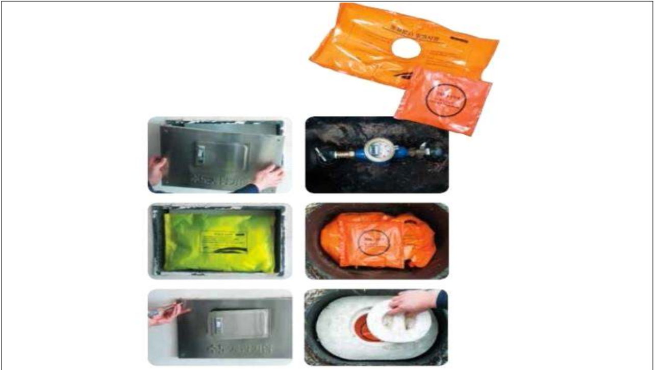
수도계량기 동파방지 보온통(팩) 설치
